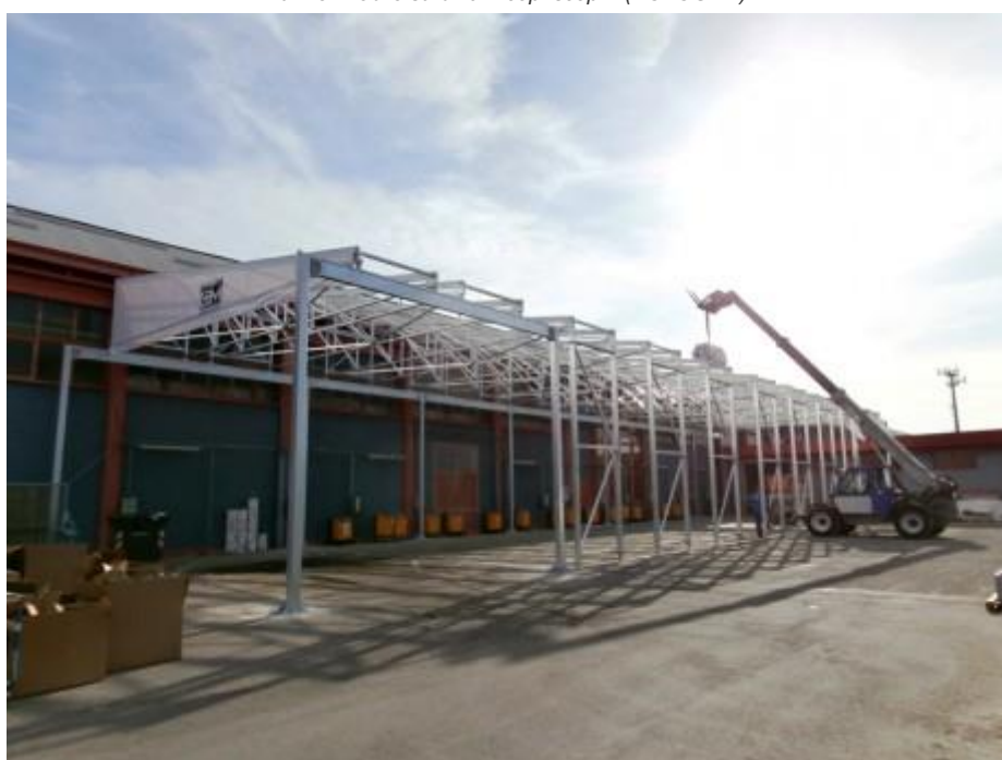
Tunnel Mobile su binari "copriscopri" (BOLOGNA)
