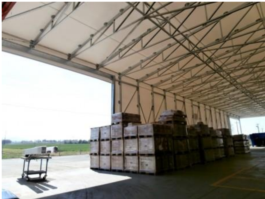
Tunnel acciaio PVC su binari "copriscopri" (BOLOGNA)
