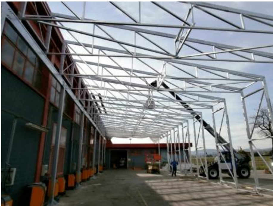
Tunnel Mobile su binari “copriscopri” (BOLOGNA)
