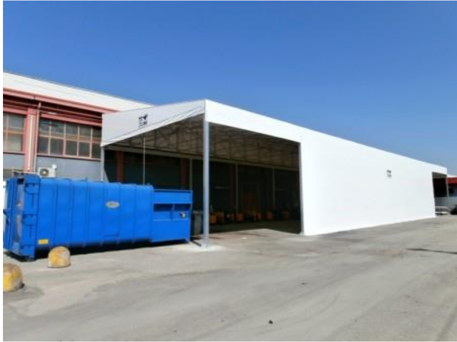
Tunnel Mobile su binari "copriscopri" (BOLOGNA)
