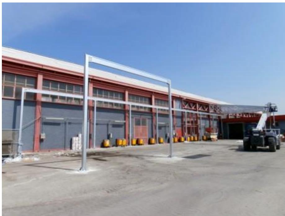
Tunnel Mobile su binari "copriscopri" (BOLOGNA)
