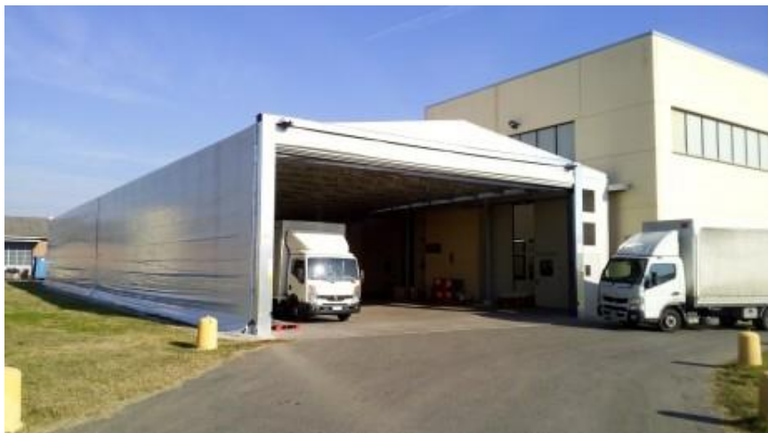
Tunnel copriscopri (BOLOGNA)
