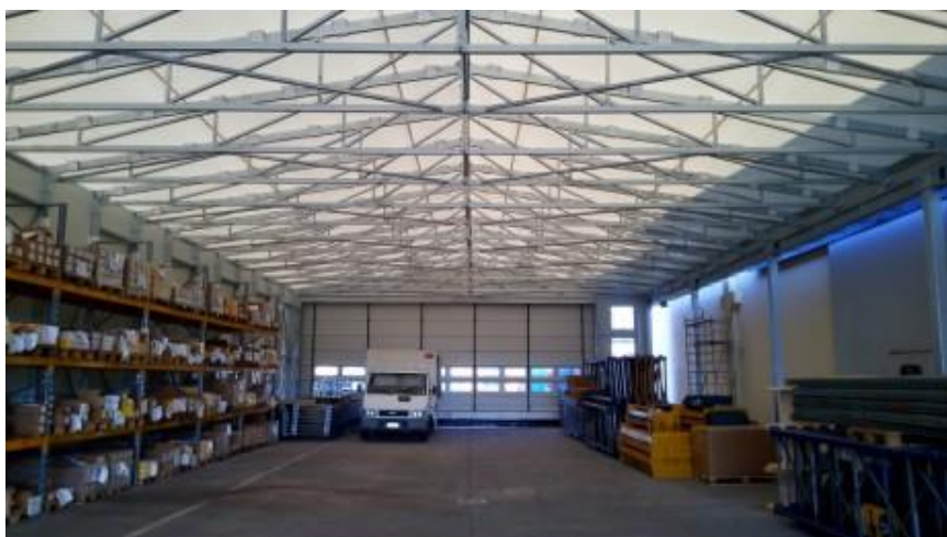
Tunnel copriscopri (BOLOGNA)
