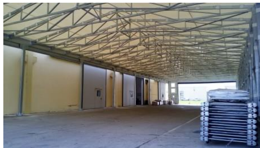
Tunnel copriscopri (BOLOGNA)
