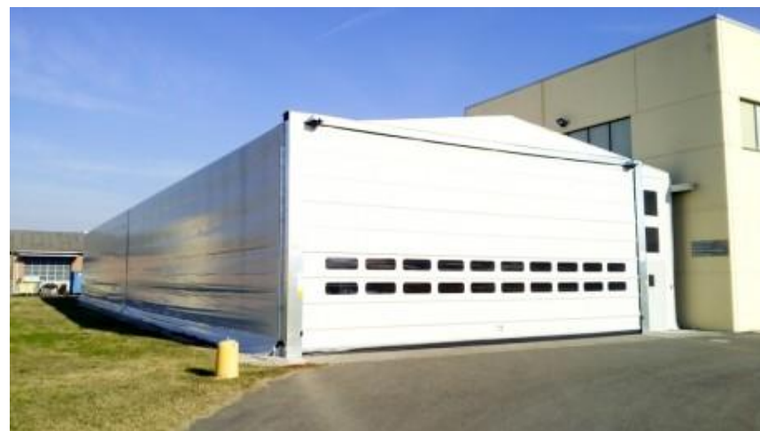
Tunnel copriscopri (BOLOGNA)
