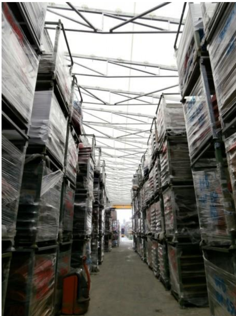
Tettoia acciaio, copertura di PVC (REGGIO EMILIA)
