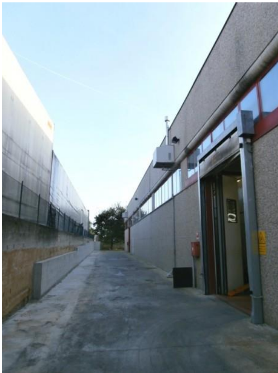
Tettoia d'acciaio, copertura di PVC (REGGIO EMILIA)
