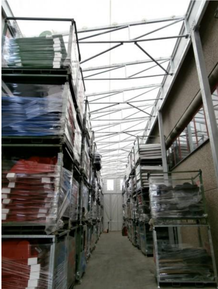
Tettoia d'acciaio, copertura di PVC (REGGIO EMILIA)
