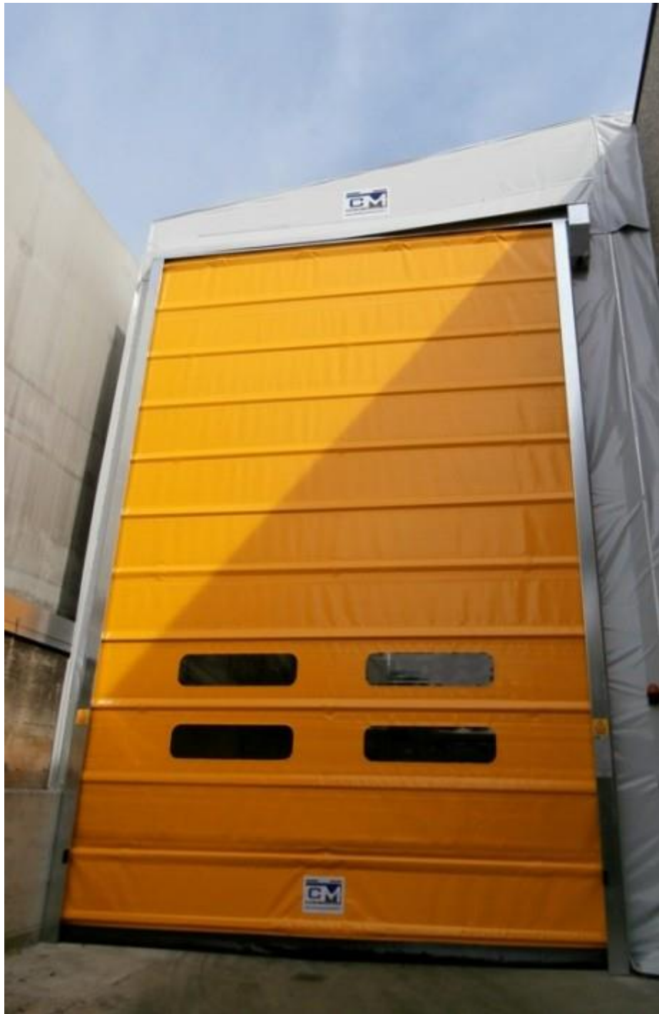
Tettoia acciaio, copertura di PVC (REGGIO EMILIA)
