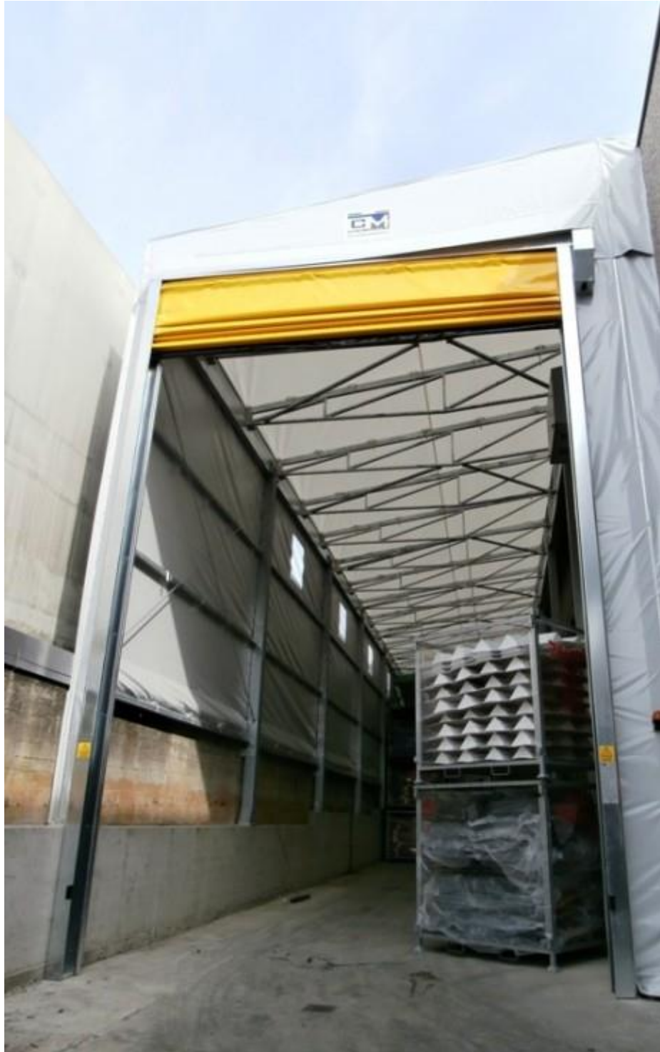
Tettoia d'acciaio, copertura di PVC (REGGIO EMILIA)
