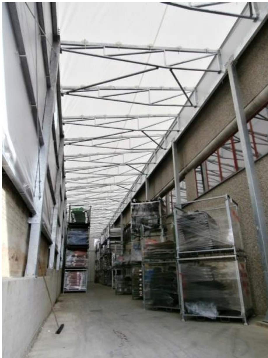
Tettoia d'acciaio, copertura di PVC (REGGIO EMILIA)
