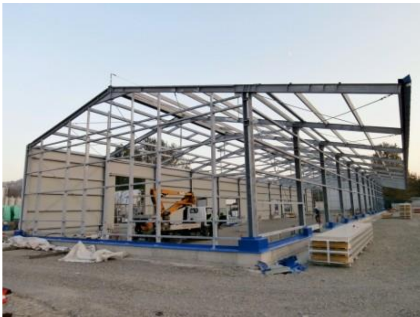
Chiusura con pannelli capannone prefabbricato
