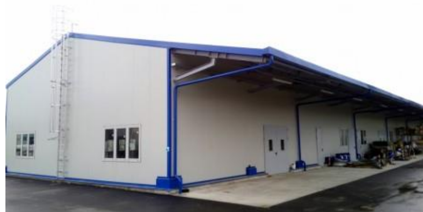
Capannone con porte e portoni ed infissi in alluminio
