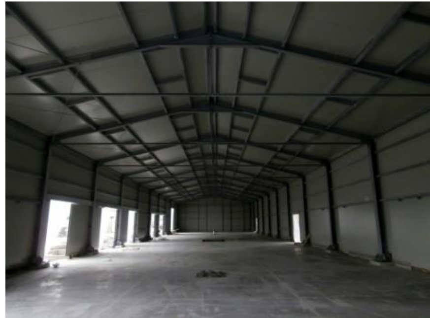
Capannone d'acciaio prefabbricato (BOLOGNA)
