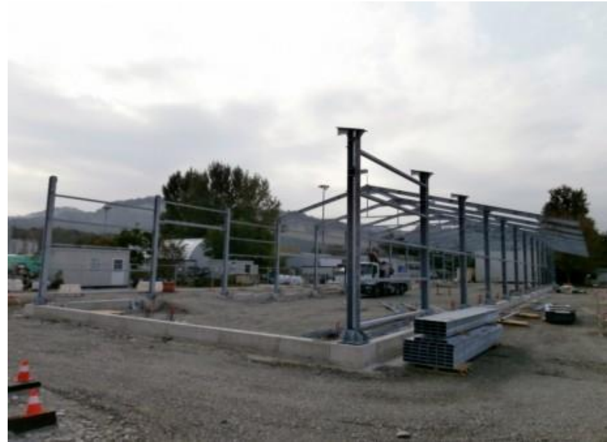
Avanzamento montaggio prefabbricato (BOLOGNA)
