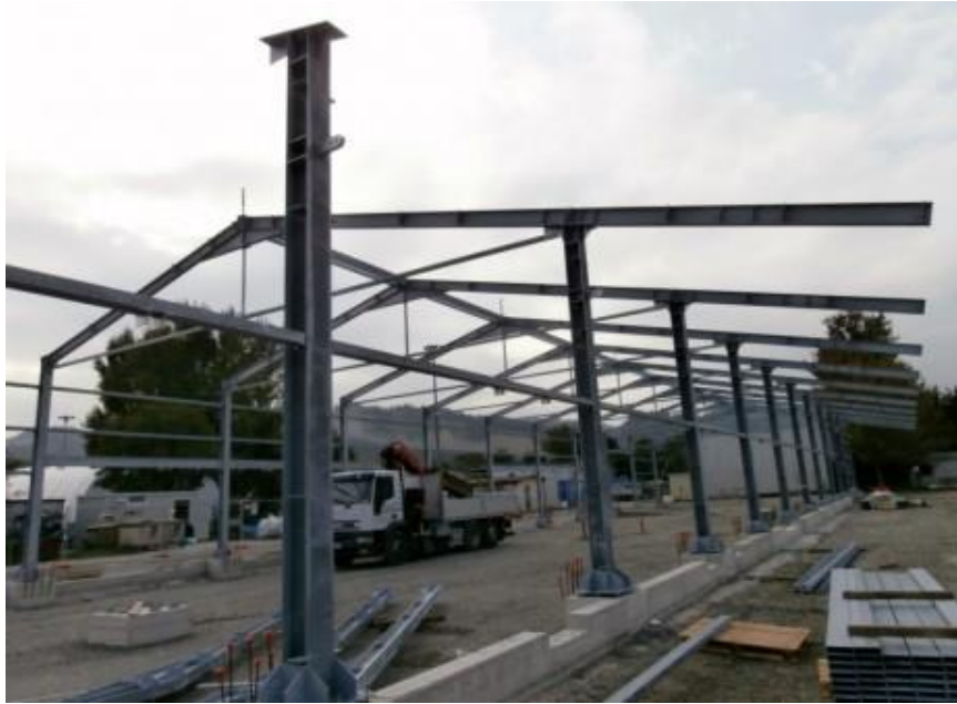
Particolare della struttura d'acciaio (BOLOGNA)
