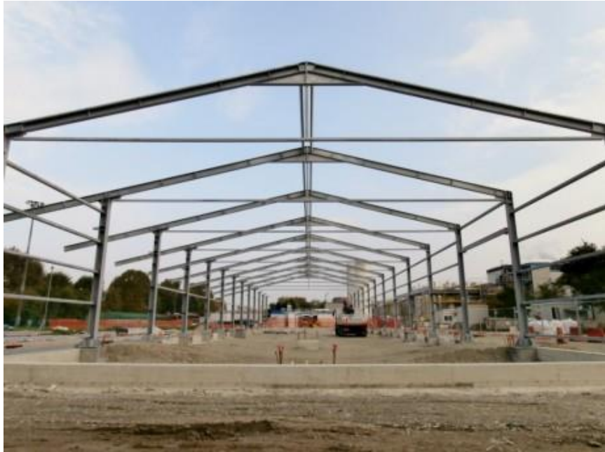
Vista del capannone in acciaio
