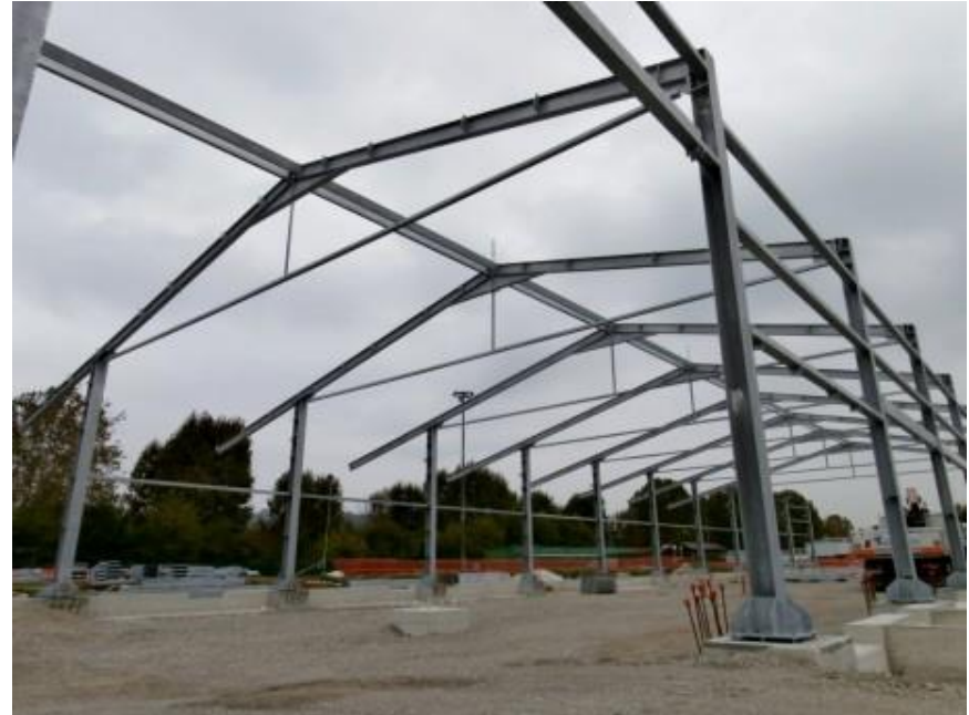
Struttura prefabbricata (BOLOGNA)
