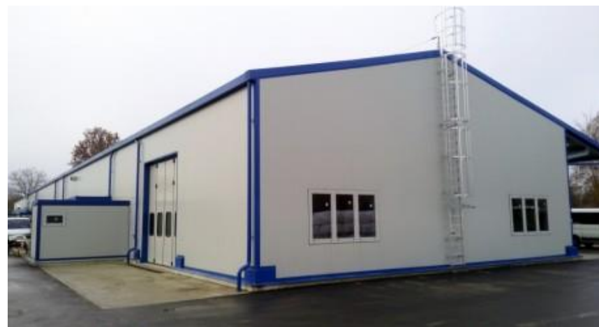
Capannone d'acciaio con porte a libro e infissi
