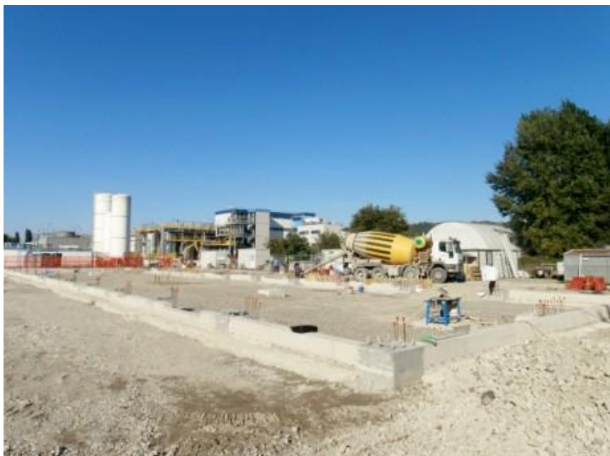
Fondamenta Capannone prefabbricato (BOLOGNA)
