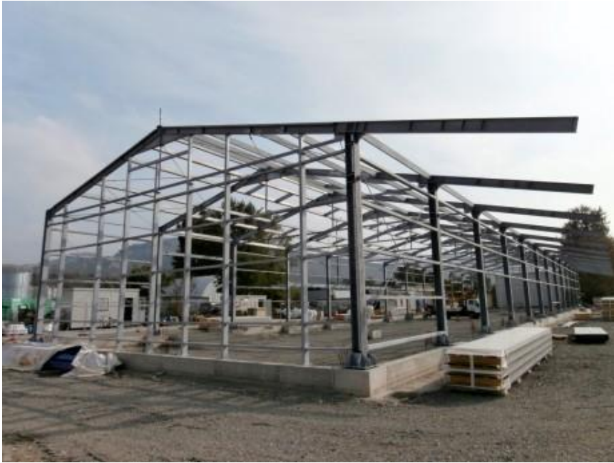
Finitura struttura prefabbricato (BOLOGNA)
