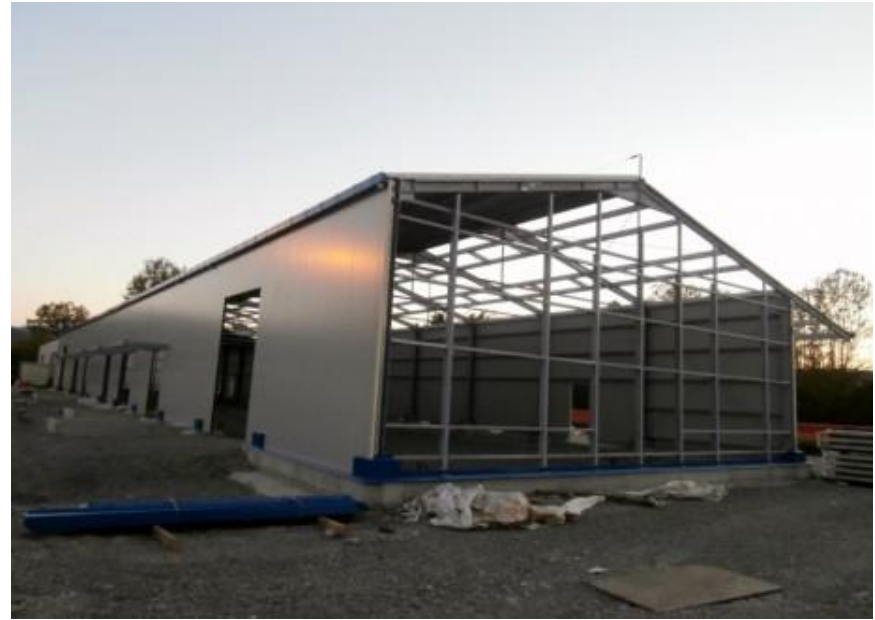
Pannellatura per Capamone in acciaio prefabbricato
