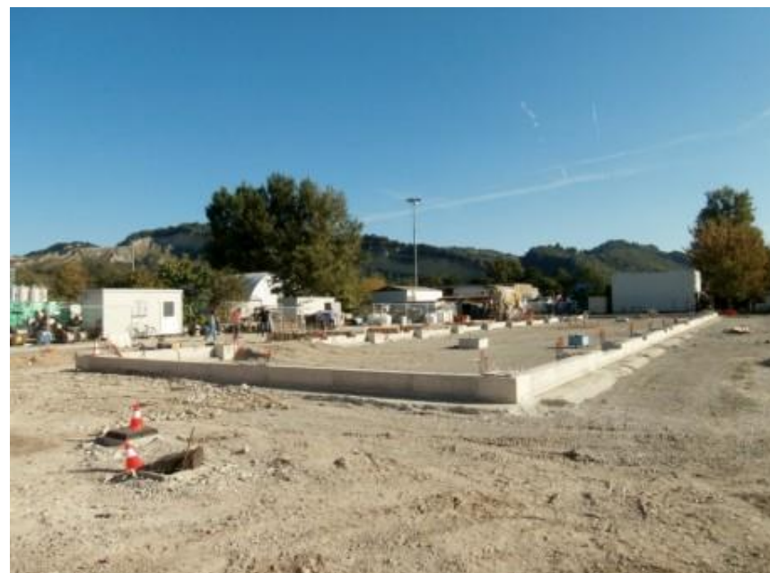
Posa fondamenta per prefabbricato in acciaio (BOLOGNA)
