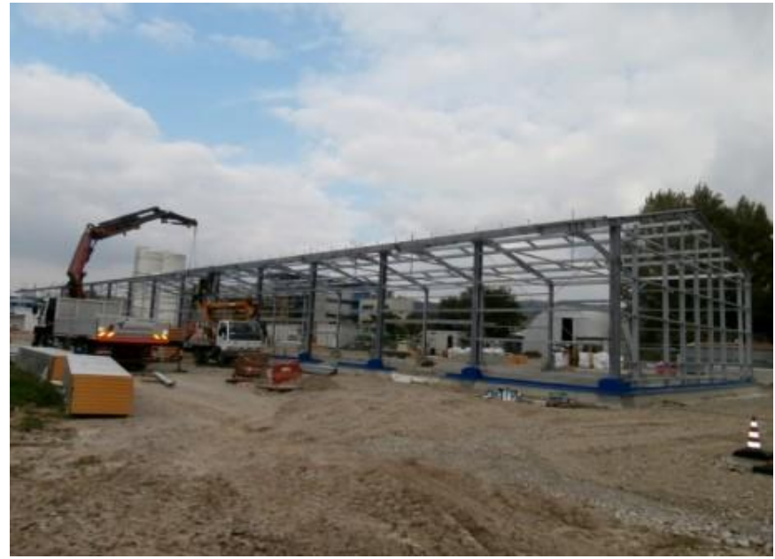
Struttura d'acciaio industriale (BOLOGNA)
