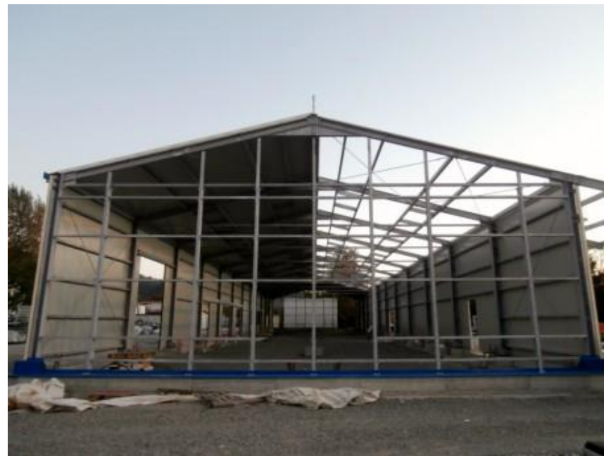
Capannone d'acciaio prefabbricato (BOLOGNA)
