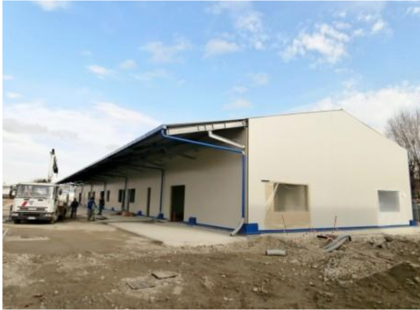
Capannone in acciaio (BOLOGNA)
