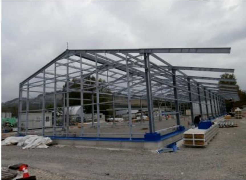
Capannone a BOLOGNA
