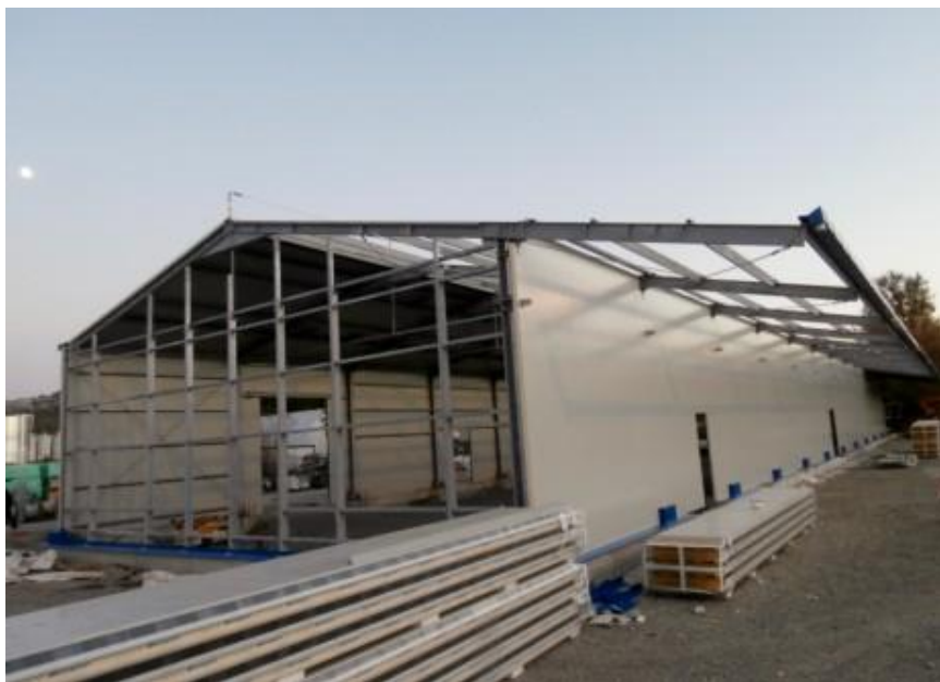
Capannone d'acciaio prefabbricato (BOLOGNA)
