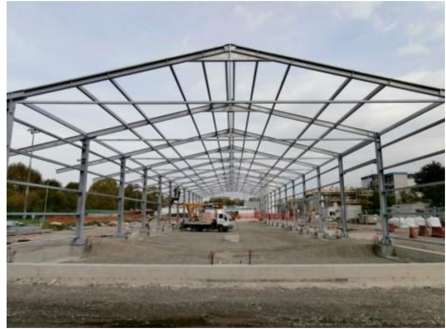
Capannone industriale in acciaio (BOLOGNA)
