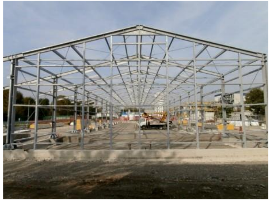
Capannone prefabbricato in acciaio (BOLOGNA)
