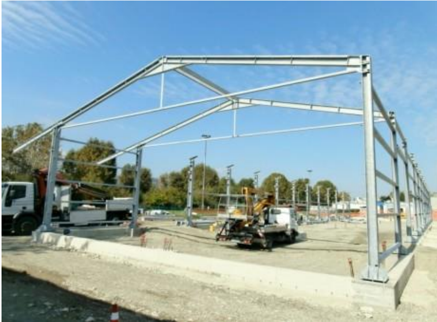
Prefabbricato in struttura d'acciaio (BOLOGNA)
