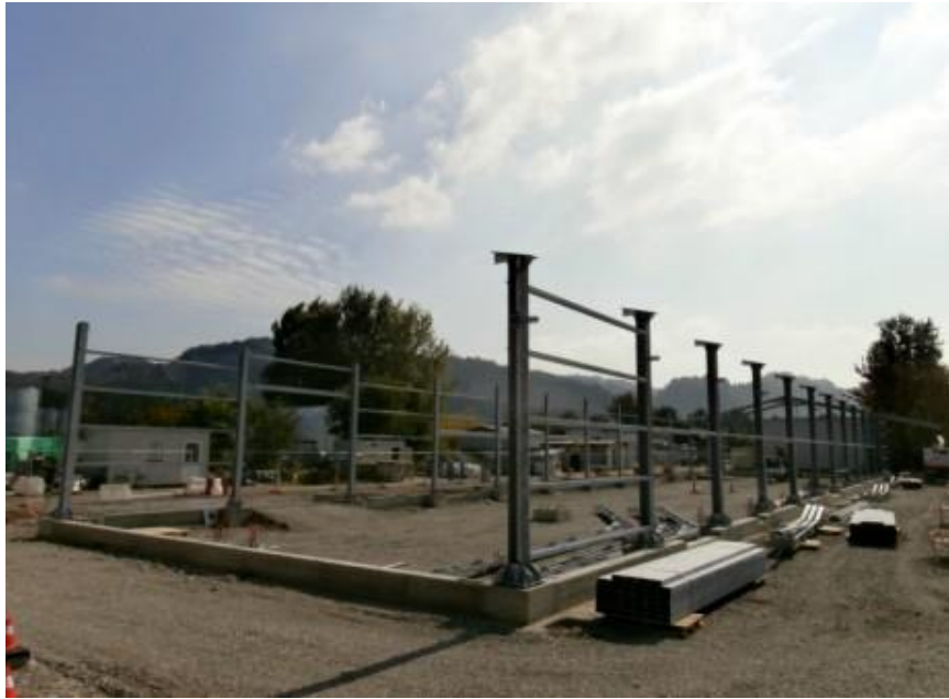
Struttura portante capannone
