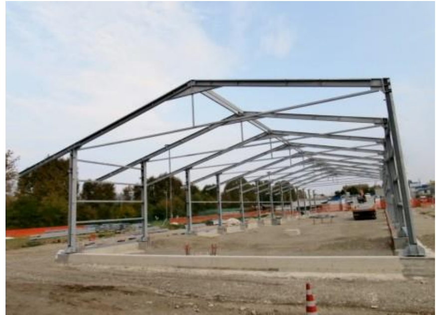
Struttura d'acciaio prefabbricato (BOLOGNA)
