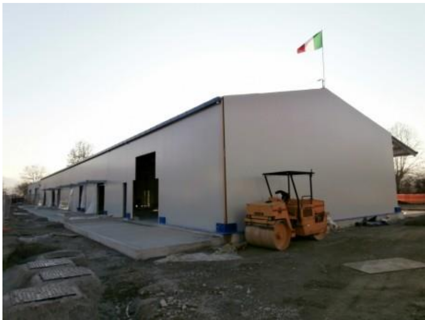
Vista del Capannone prefabbricato
