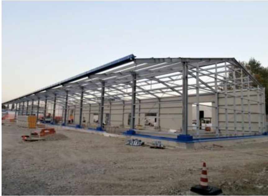
Pannellatura manufatto in acciaio
