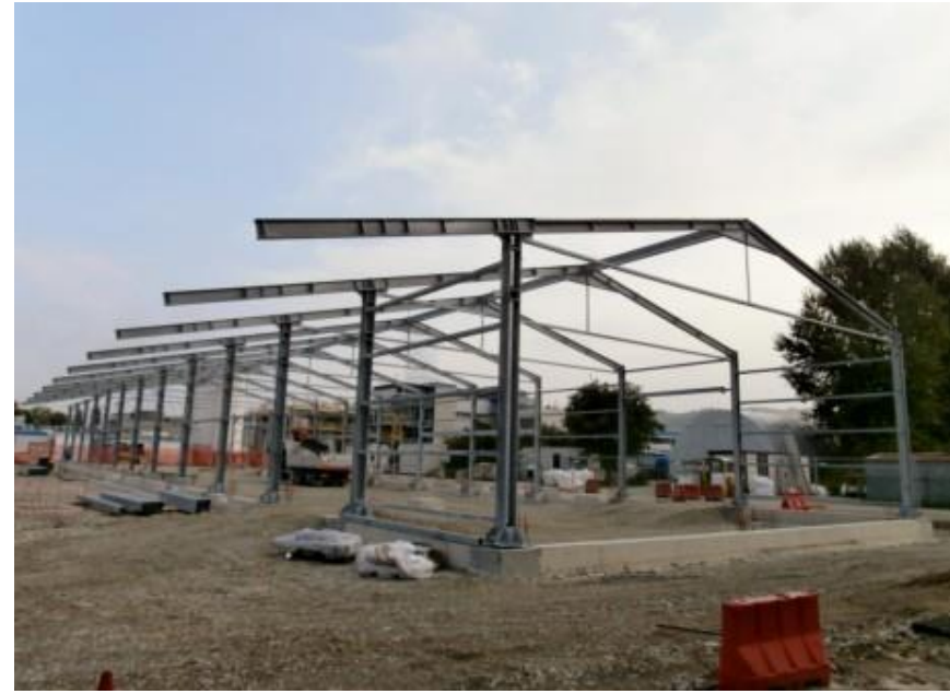
Costruzione capannone (BOLOGNA)
