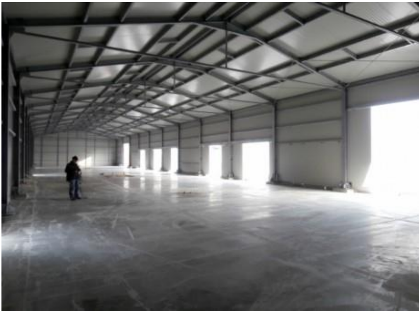
Interno copertura industriale prefabbricato (BOLOGNA)
