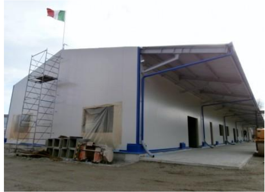
Capannone in allestimento
