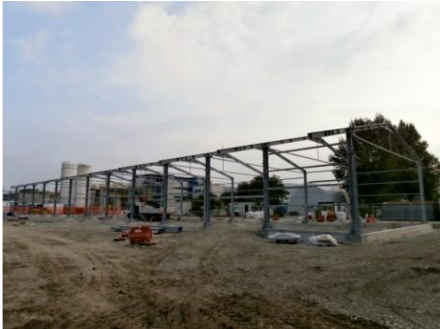
Capannone in costruzione (BOLOGNA)
