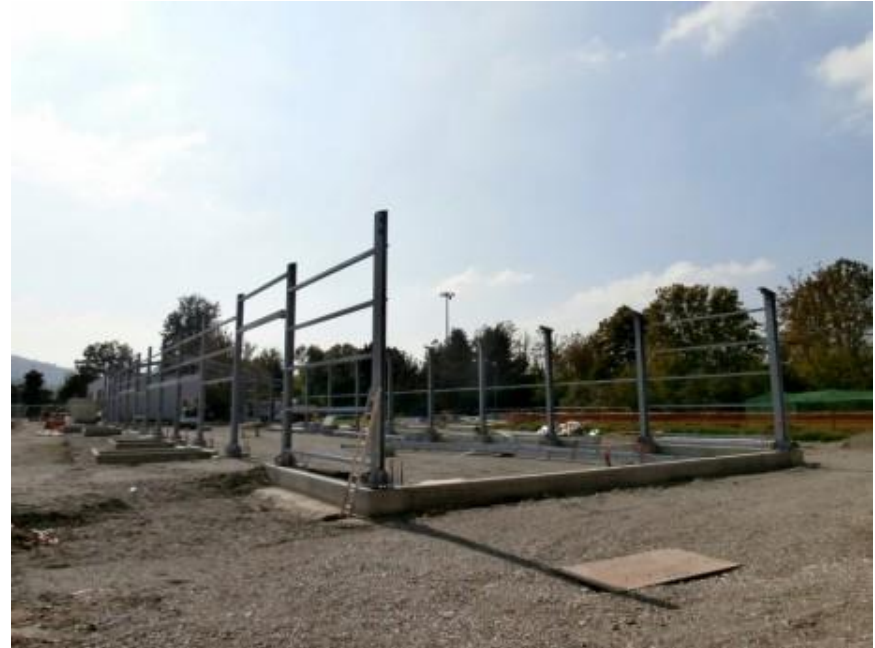
Piloni della struttura portante del capannone
