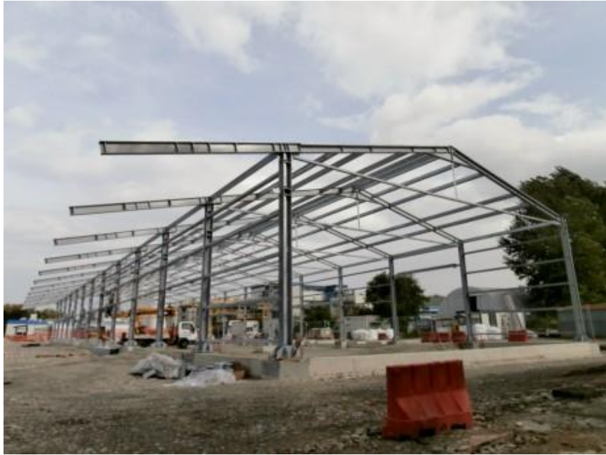
Prefabbricato (BOLOGNA) in acciaio
