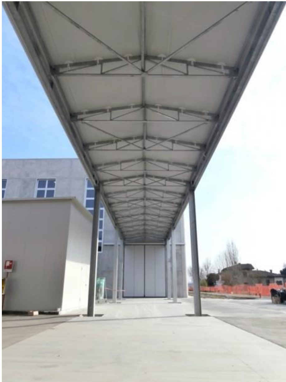
Tunnel mobile di collegamento (BOLOGNA)
