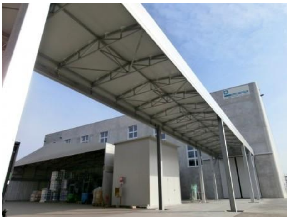
Tunnel mobile di collegamento (BOLOGNA)
