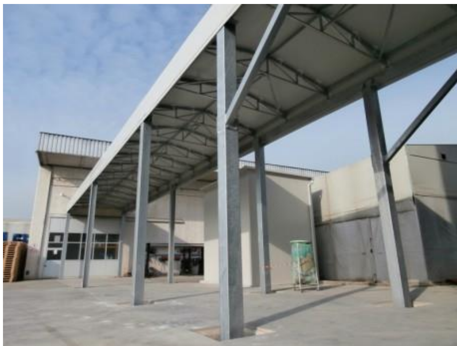
Tunnel mobile di collegamento (BOLOGNA)
