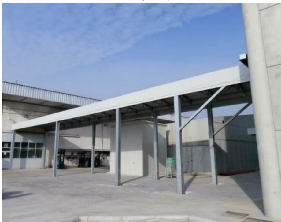
Tunnel mobile di collegamento (BOLOGNA)
