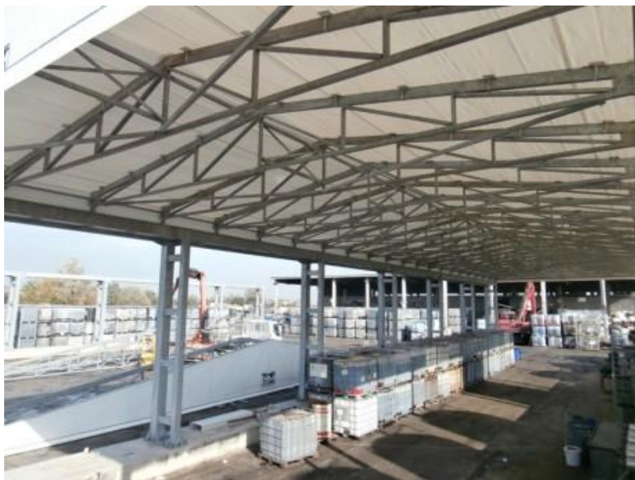
Tettoia d'acciaio con tetto di pvc "copriscopri" (PIACENZA)
