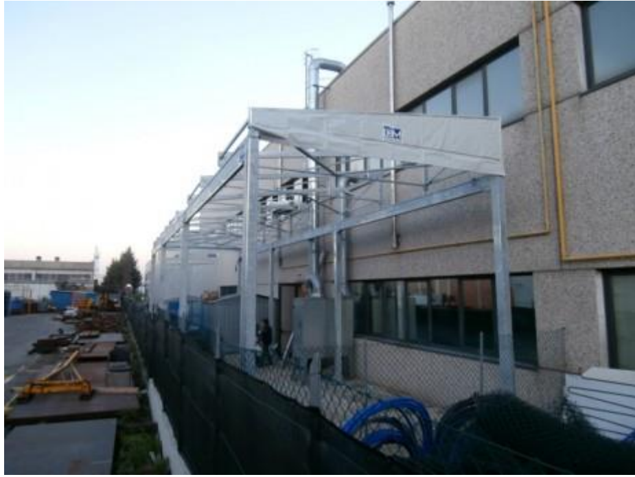
CM – tettoia mobile “tunnel copri-scopri” (BOLOGNA)
