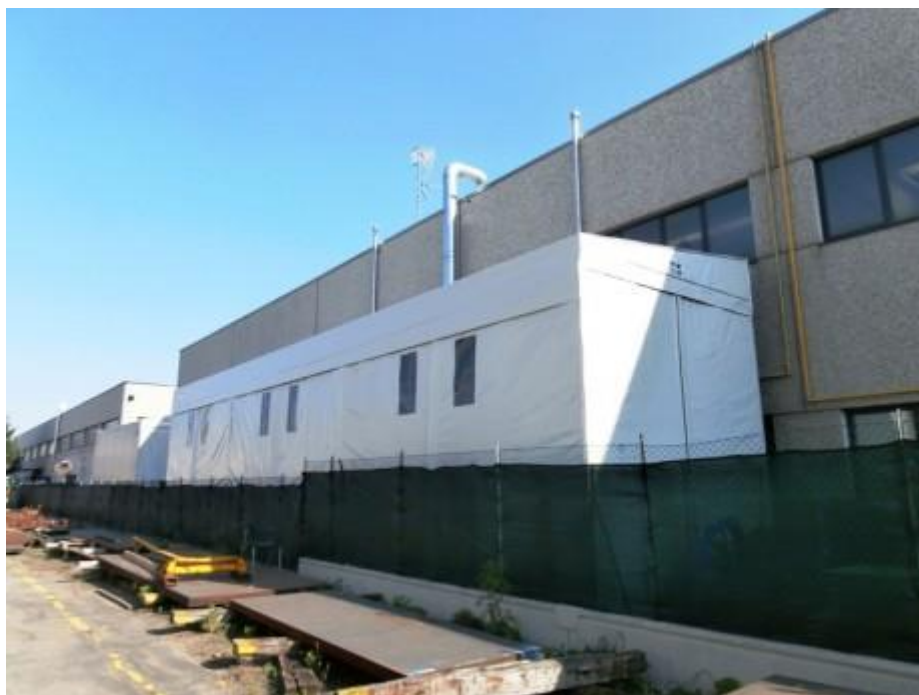
CM – tettoia mobile “tunnel copri-scopri” (BOLOGNA)
