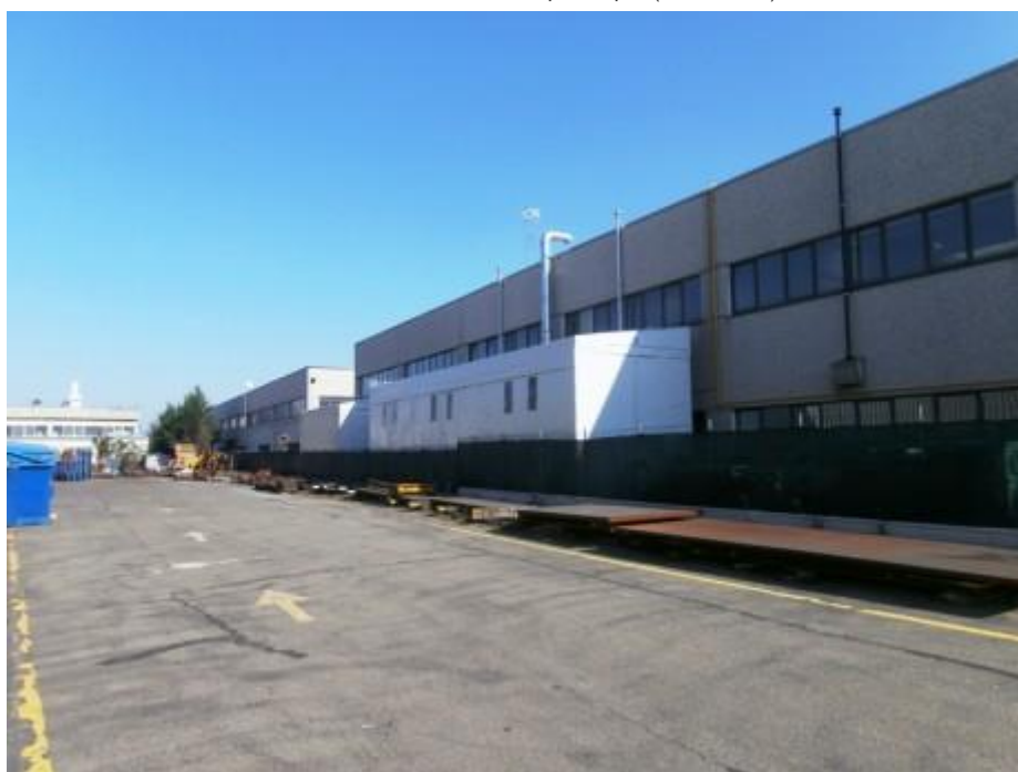
CM – tettoia mobile “tunnel copri-scopri” (BOLOGNA)
