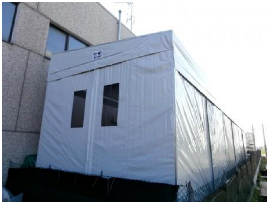
CM – tettoia mobile “tunnel copri-scopri” (BOLOGNA)
