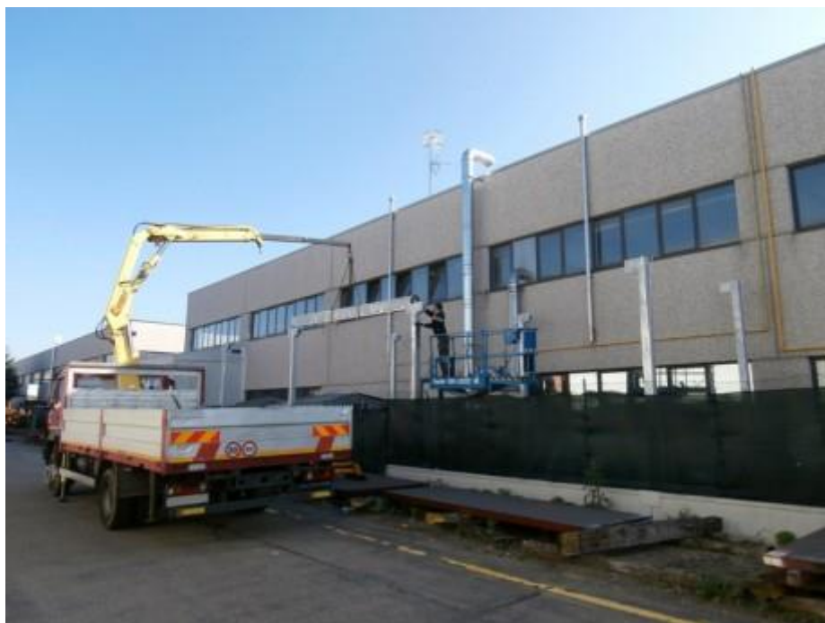
CM – tettoia mobile “tunnel copri-scopri” (BOLOGNA)
