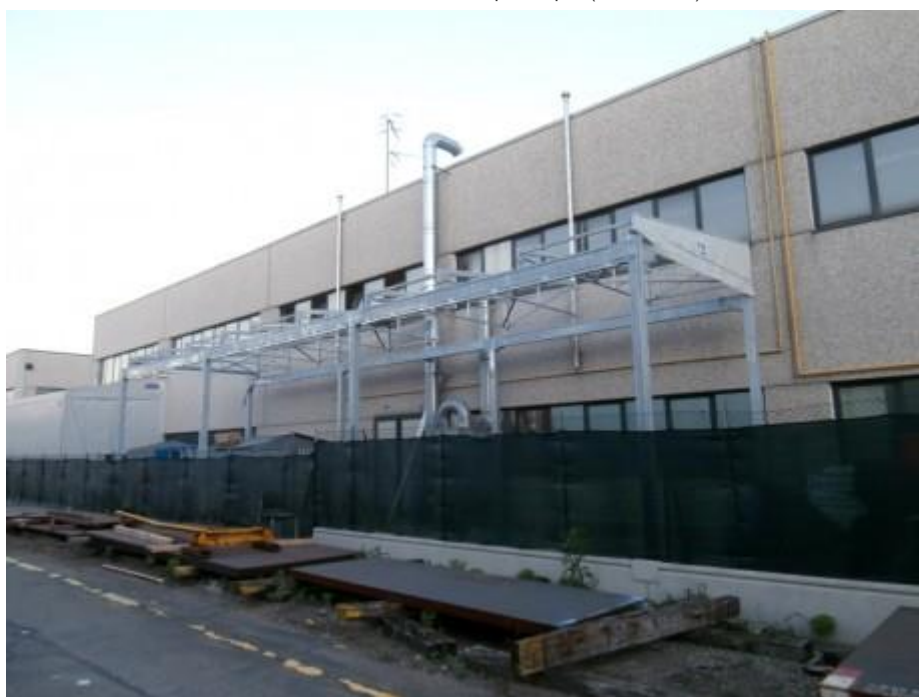
CM – tettoia mobile “tunnel copri-scopri” (BOLOGNA)
