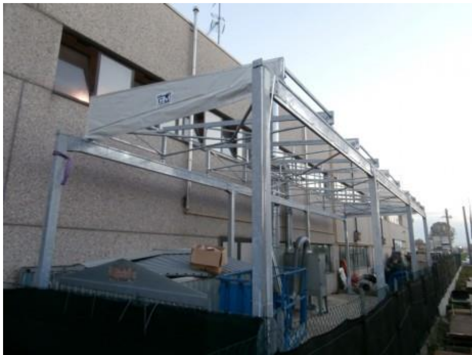
CM – tettoia mobile “tunnel copri-scopri” (BOLOGNA)
