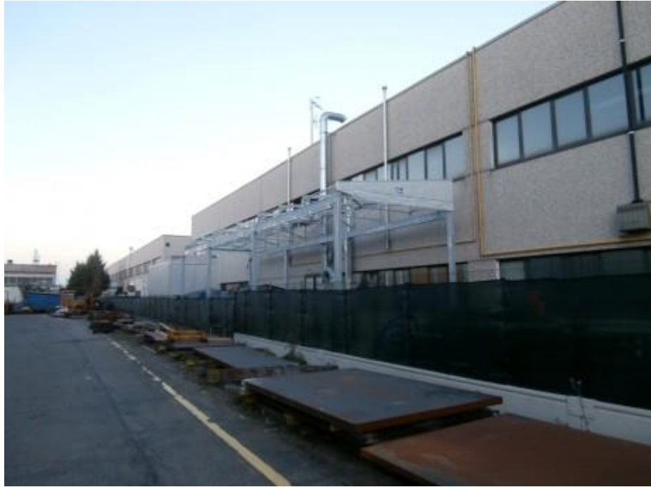
CM – tettoia mobile “tunnel copri-scopri” (BOLOGNA)
