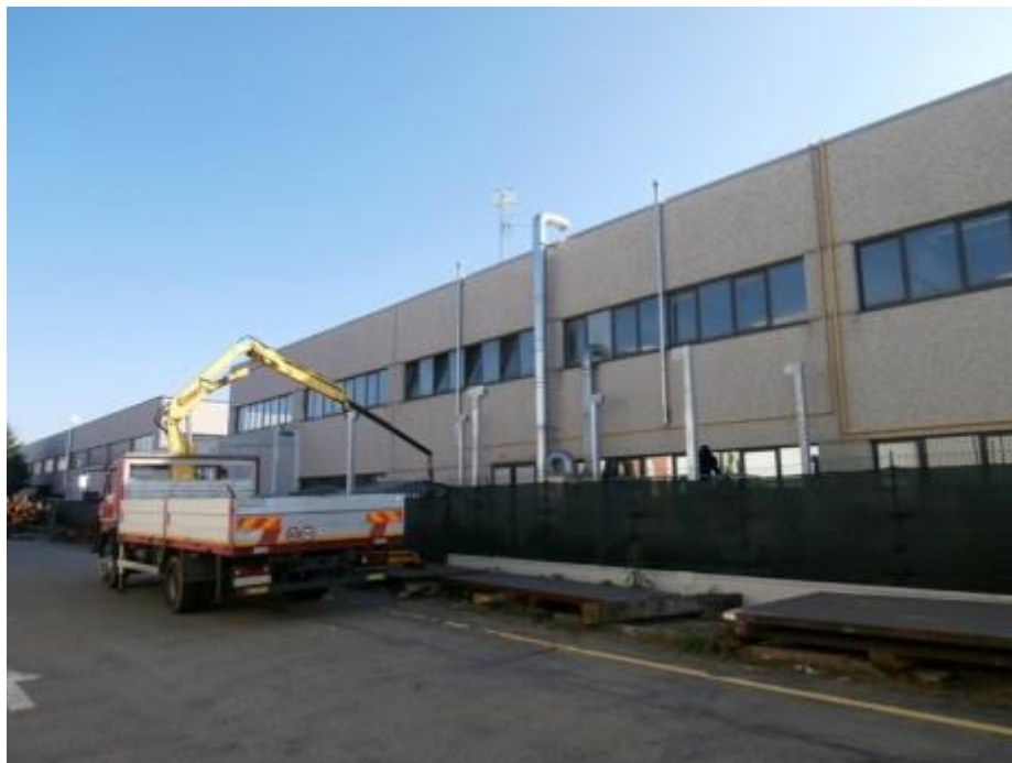
CM – tettoia mobile “tunnel copri-scopri” (BOLOGNA)
