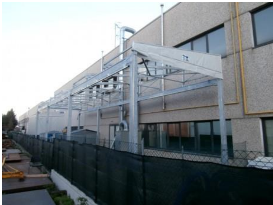
CM – tettoia mobile “tunnel copri-scopri” (BOLOGNA)
