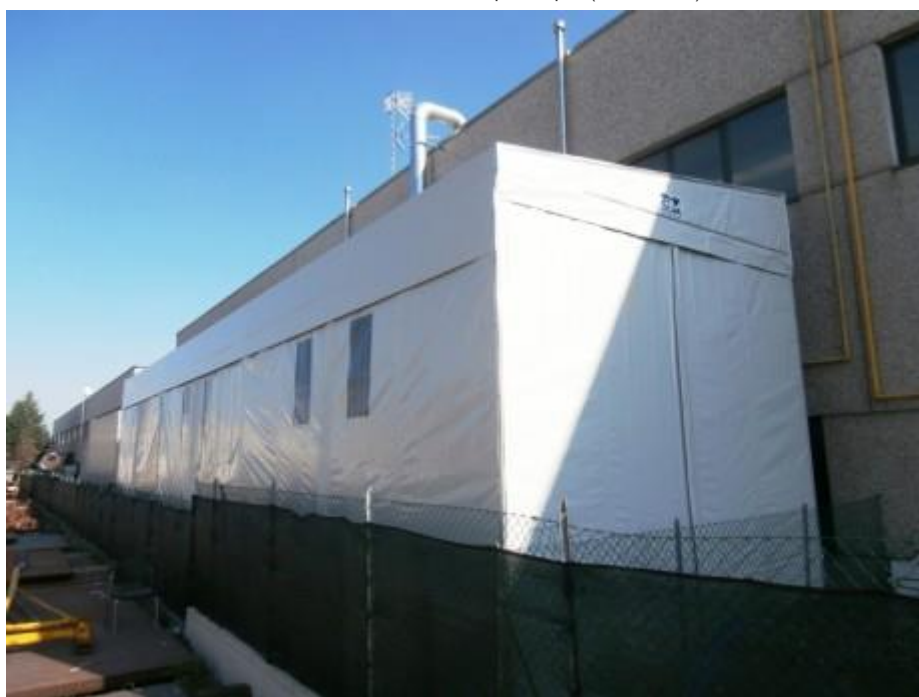
CM – tettoia mobile “tunnel copri-scopri” (BOLOGNA)
