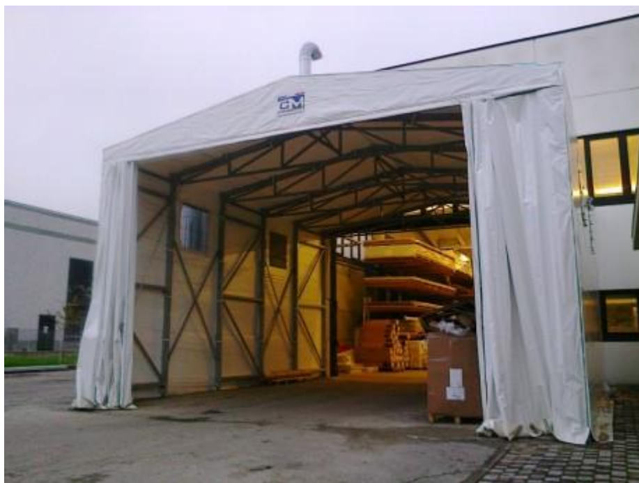
C.M. – tunnel mobile su ruote (BOLOGNA)
