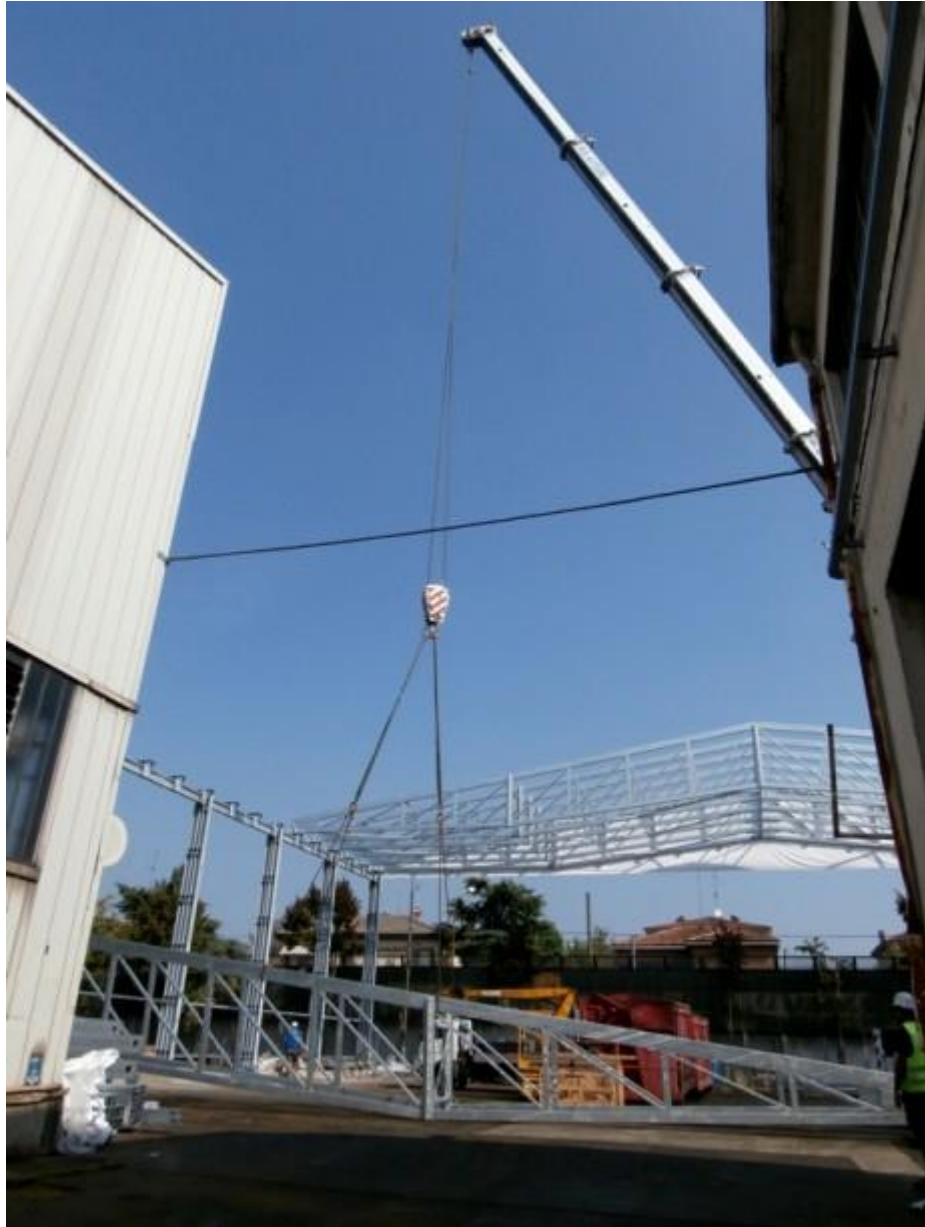
C.M. MEGA-STRUTTURA, TETTOIA d'ACCIAIO con TETTO APRIBILE (MODENA)
