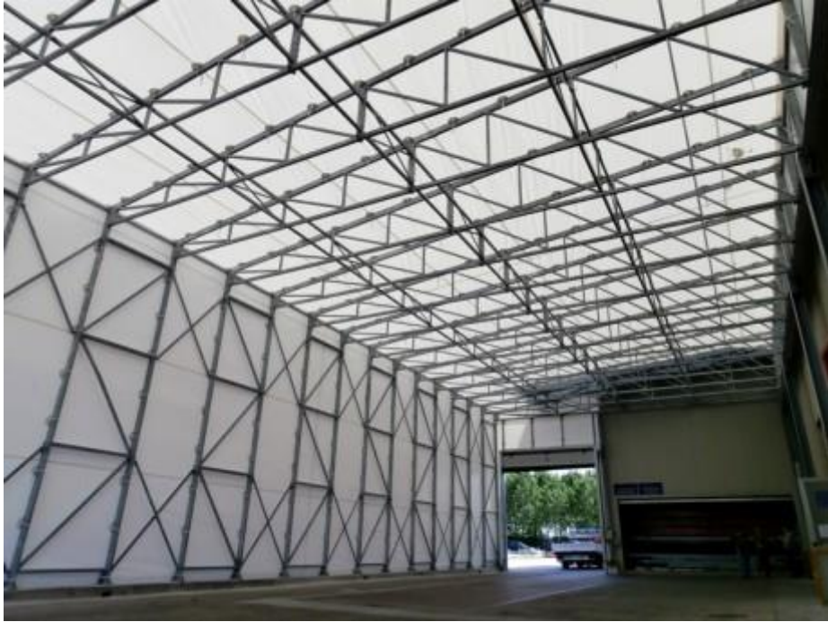
C.M. – CAPANNONE d'ACCIAIO rivestito di PVC (TREVISO)
