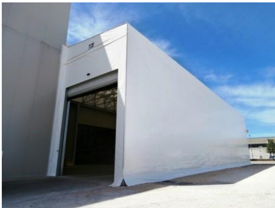
C.M. – CAPANNONE d'ACCIAIO rivestito di PVC (TREVISO)
