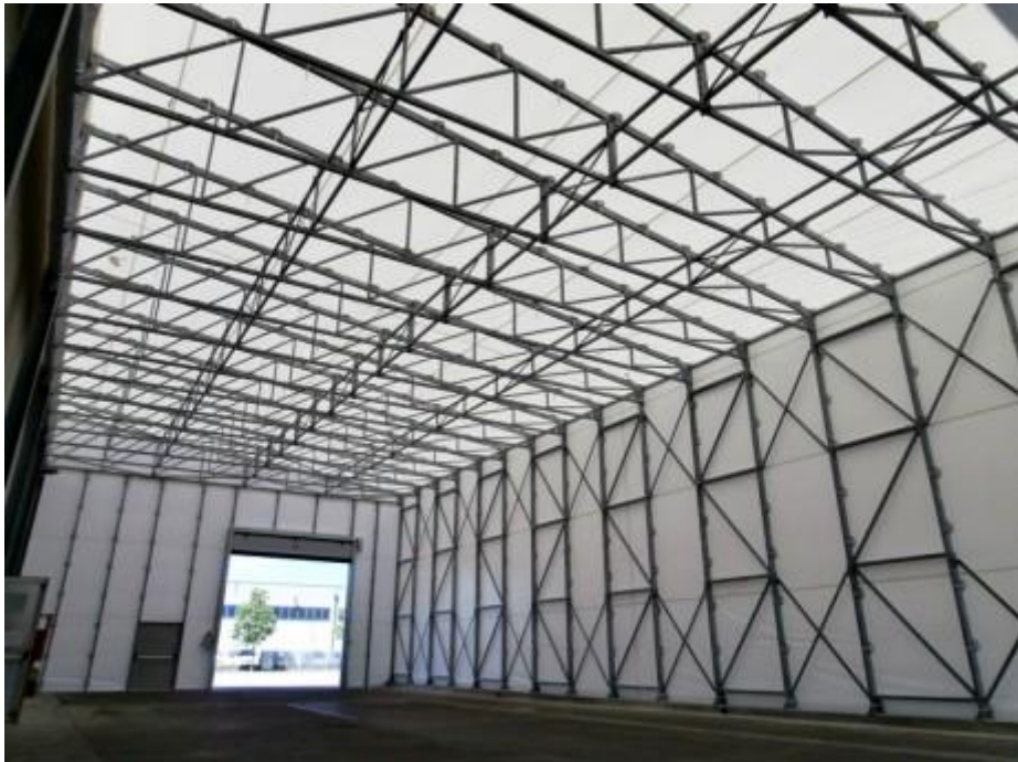
C.M. – CAPANNONE d'ACCIAIO rivestito di PVC (TREVISO)
