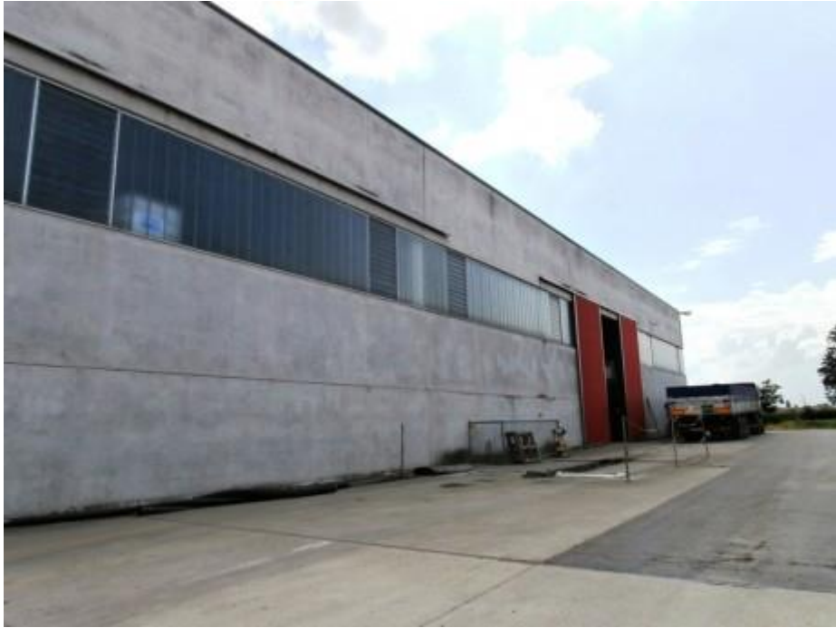
C.M. – TETTOIA MOBILE COPRI SCOPRI (REGGIO EMILIA)
