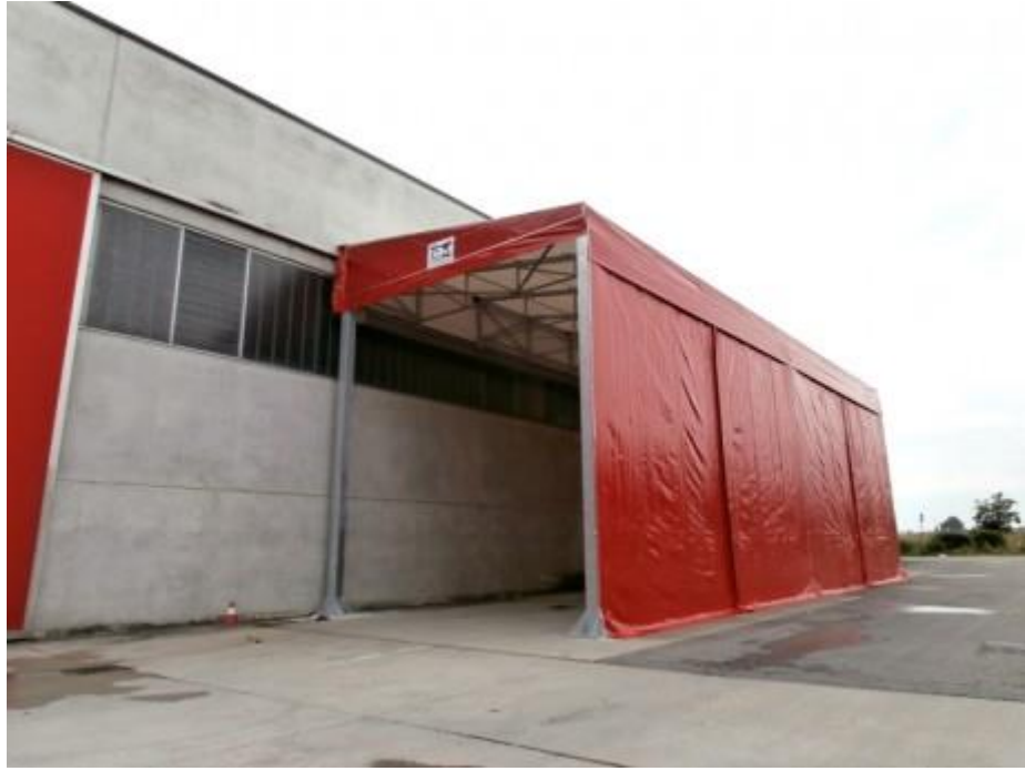
C.M. – TETTOIA MOBILE COPRI SCOPRI (REGGIO EMILIA)
