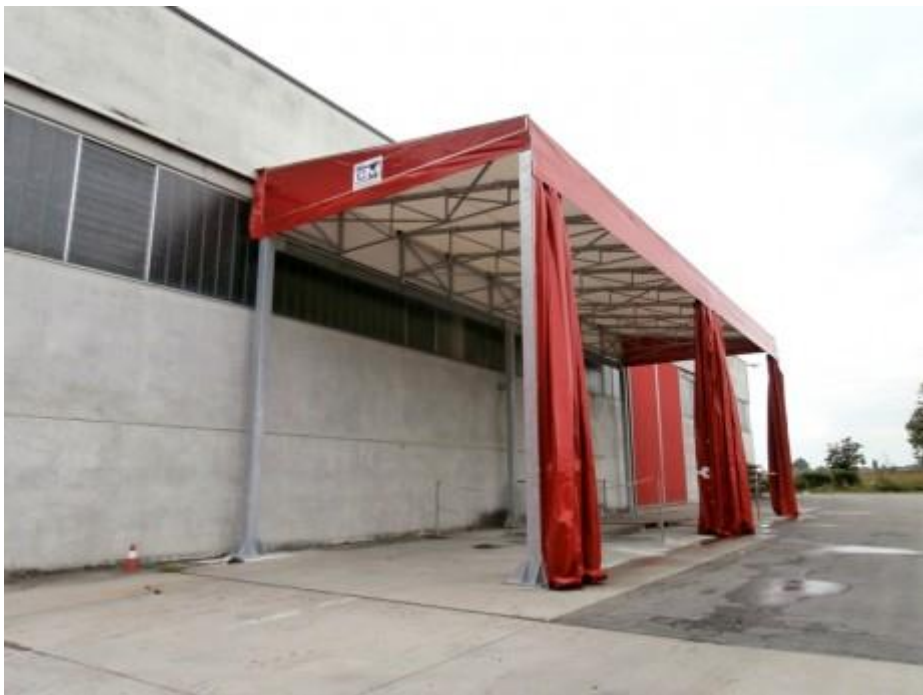
C.M. – TETTOIA MOBILE COPRI SCOPRI (REGGIO EMILIA)
