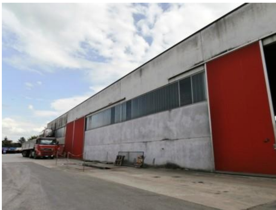
C.M. – TETTOIA MOBILE COPRI SCOPRI (REGGIO EMILIA)
