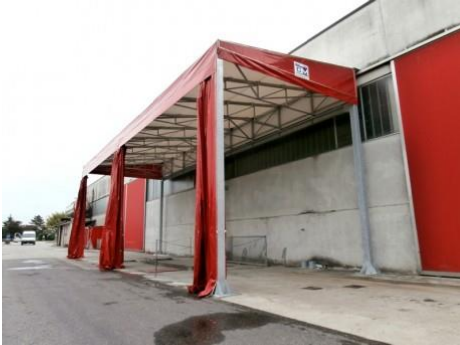
C.M. – TETTOIA MOBILE COPRI SCOPRI (REGGIO EMILIA)
