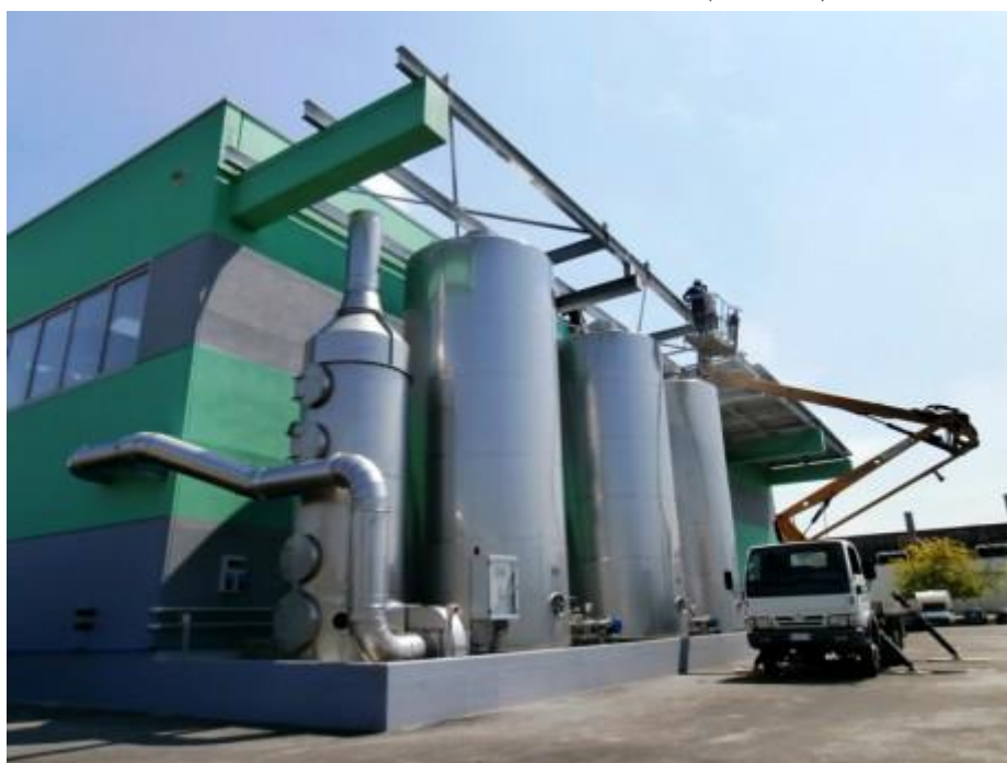
C.M. TETTOIA ACCIAIO COPERTURA PANNELLO (BOLOGNA)
