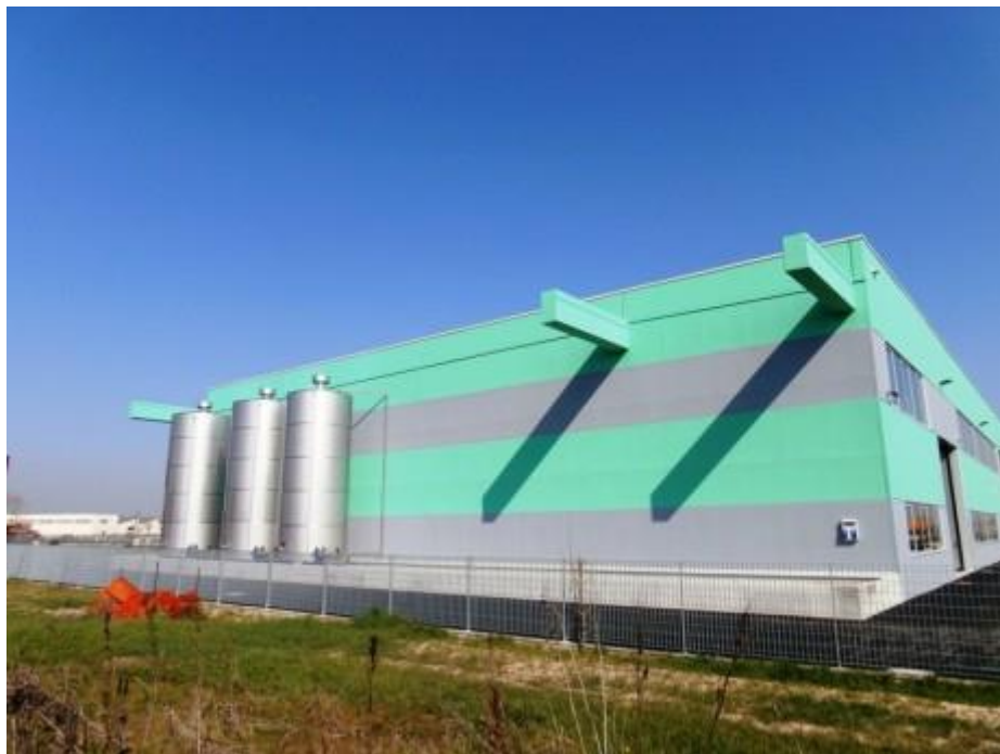
C.M. TETTOIA ACCIAIO COPERTURA PANNELLO (BOLOGNA)
