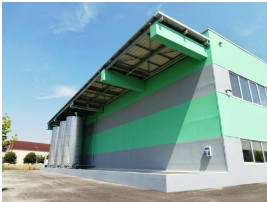
C.M. TETTOIA ACCIAIO COPERTURA PANNELLO (BOLOGNA)
