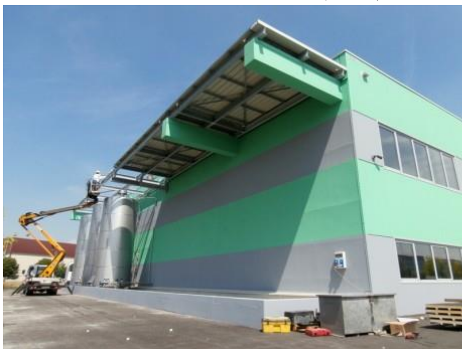
C.M. TETTOIA ACCIAIO COPERTURA PANNELLO (BOLOGNA)
