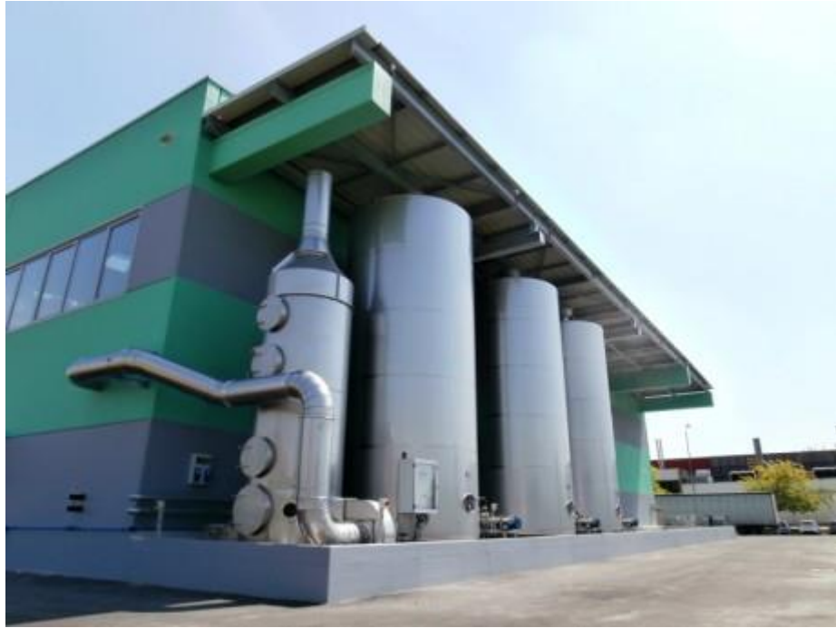
C.M. TETTOIA ACCIAIO COPERTURA PANNELLO (BOLOGNA)
