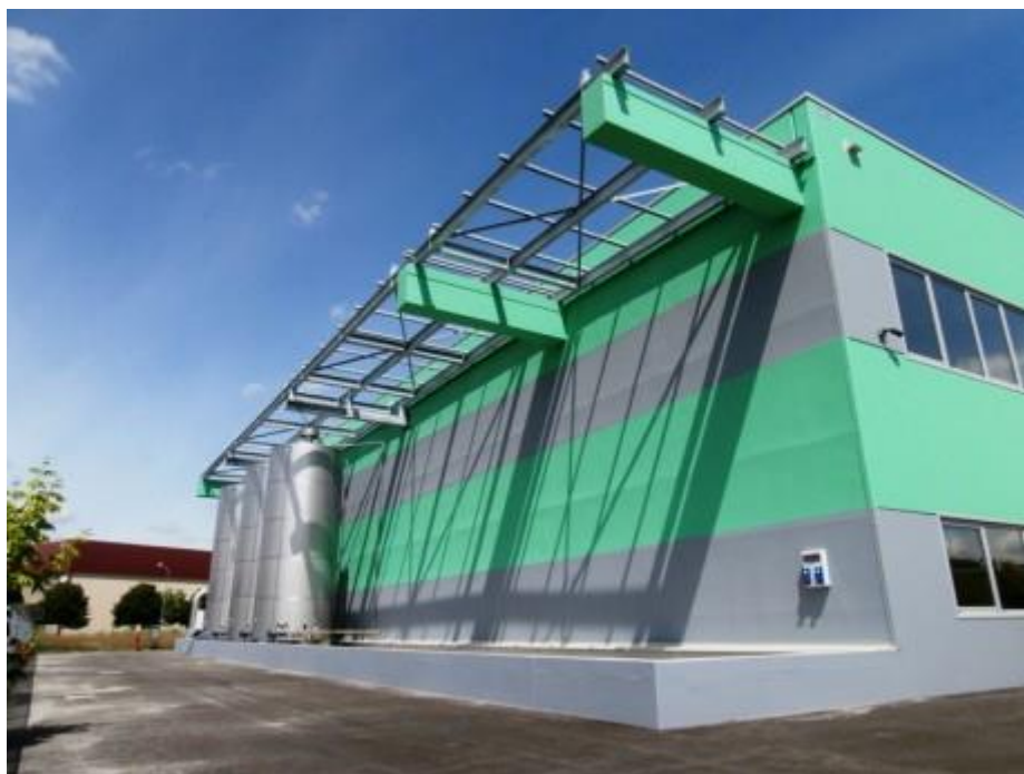
C.M. TETTOIA ACCIAIO COPERTURA PANNELLO (BOLOGNA)
