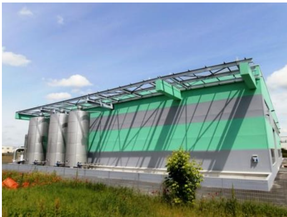
C.M. TETTOIA ACCIAIO COPERTURA PANNELLO (BOLOGNA)
