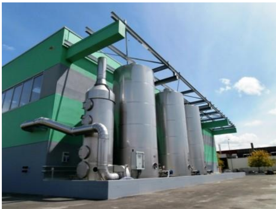
C.M. TETTOIA ACCIAIO COPERTURA PANNELLO (BOLOGNA)
