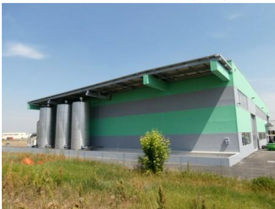
C.M. TETTOIA ACCIAIO COPERTURA PANNELLO (BOLOGNA)
