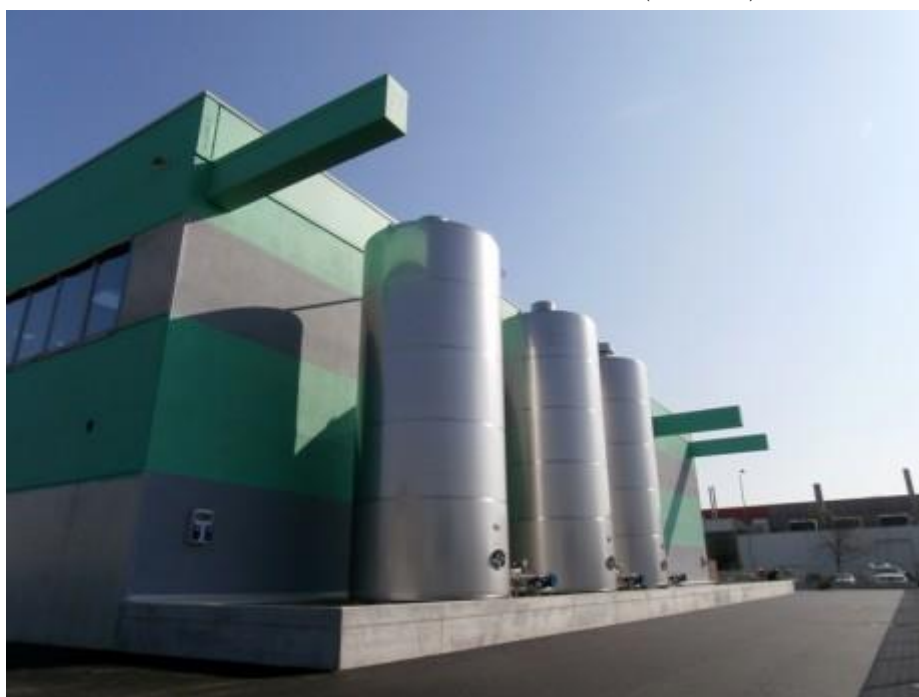
C.M. TETTOIA ACCIAIO COPERTURA PANNELLO (BOLOGNA)
