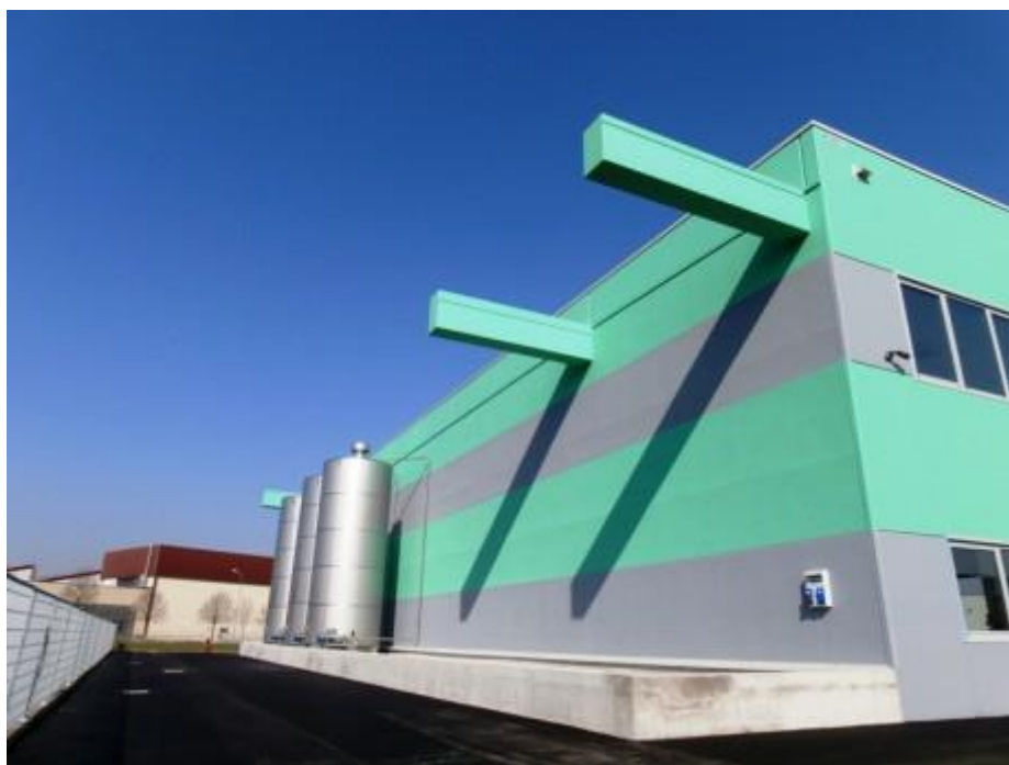
C.M. TETTOIA ACCIAIO COPERTURA PANNELLO (BOLOGNA)
