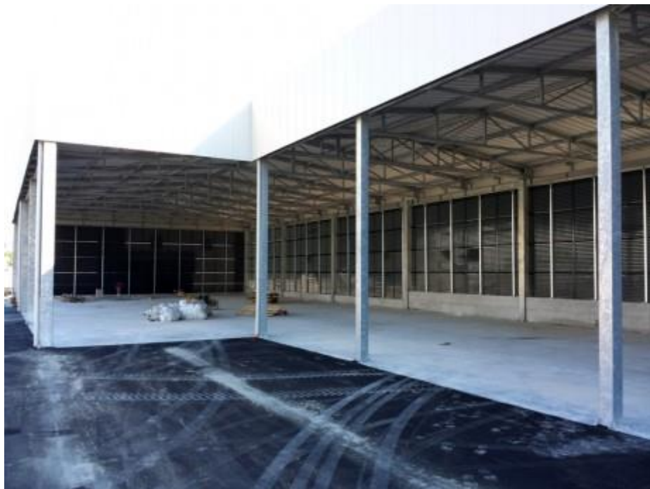
C.M. Struttura in acciaio prefabbricata + PARETI FRANGIVENTO (ANCONA)
