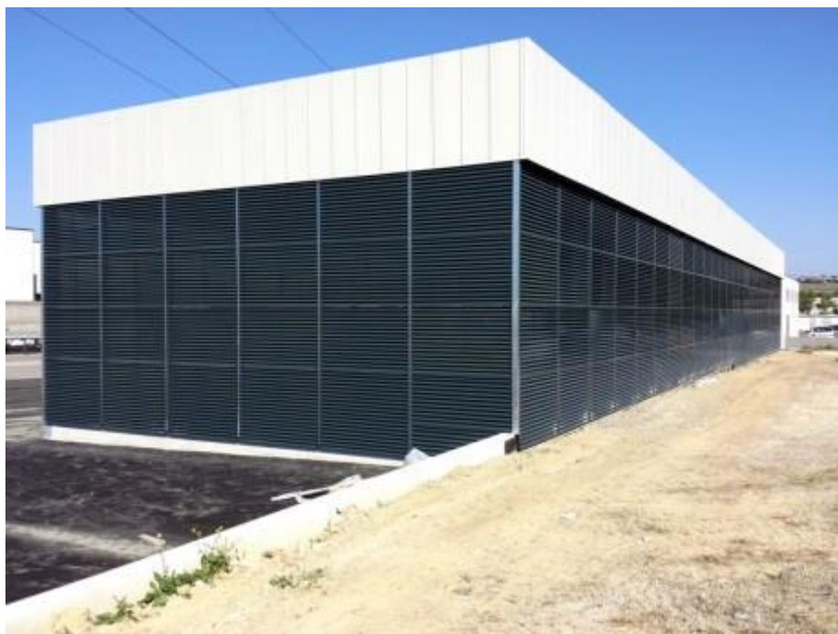
C.M. prefabbricato in acciaio + PARETI FRANGIVENTO (ANCONA)
