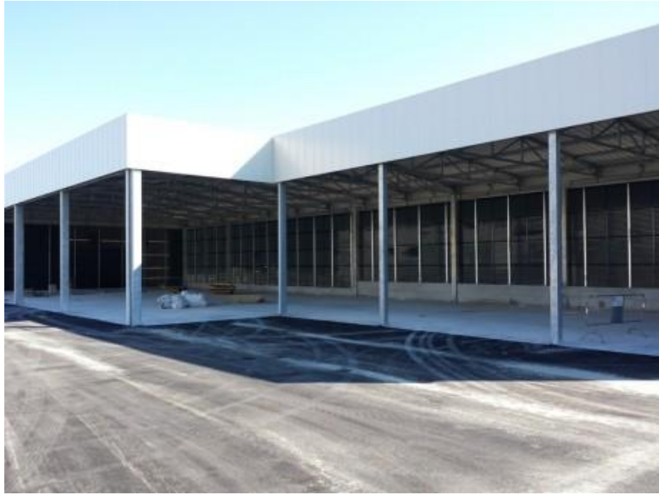
C.M. struttura autoportante prefabbricata in acciaio + PARETI FRANGIVENTO (ANCONA)
