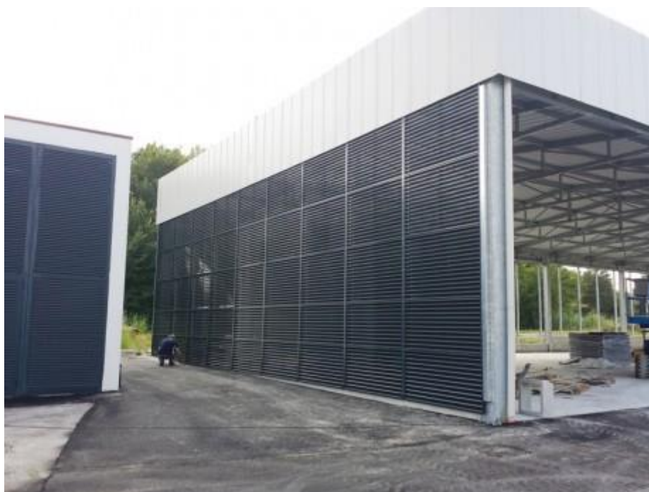
C.M. prefabbricato copertura in acciaio + PARETI FRANGIVENTO (ANCONA)
