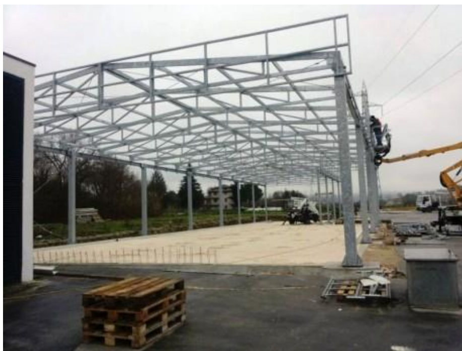
C.M. prefabbricato in acciaio + PARETI FRANGIVENTO (ANCONA)
