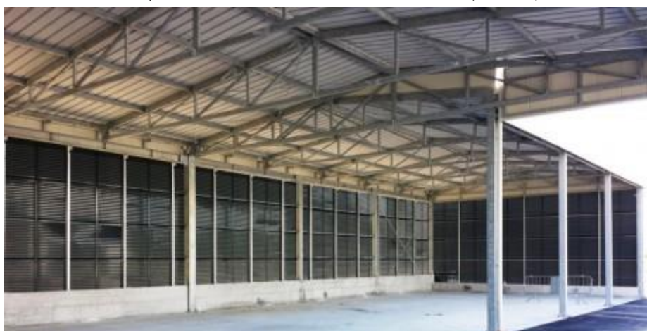
C.M. struttura prefabbricata in acciaio + PARETI FRANGIVENTO (ANCONA)
